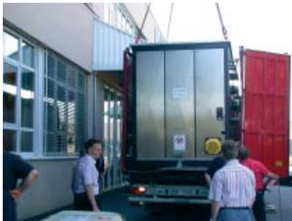
LAUDA liefert die größte Kälteanlage der Firmengeschichte aus.
